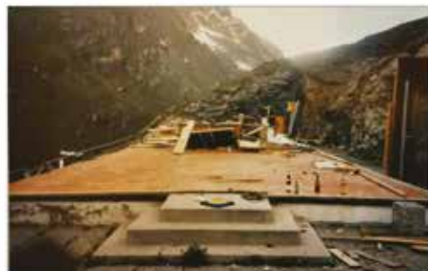
Les restes du restaurant du barrage de Moiry, détruit par l'avalanche de 1988.
