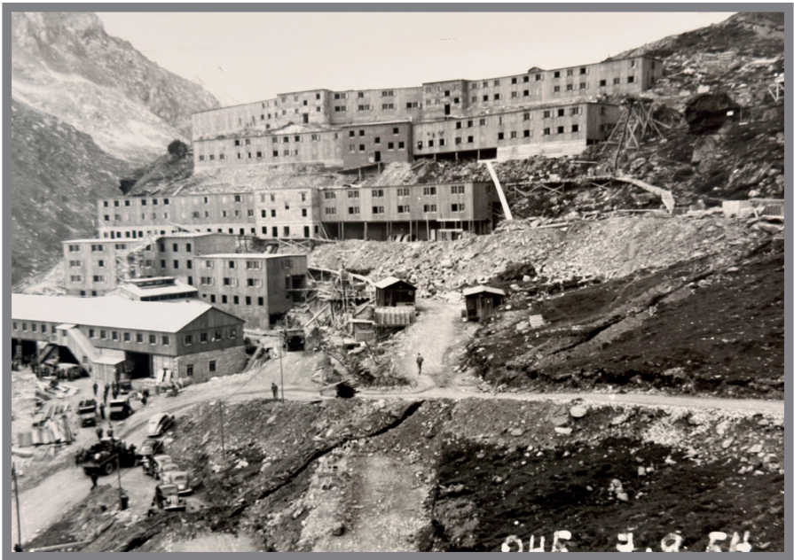
Village bâti pour les ouvriers lors de construction du mur du barrage de Moiry entre 1954 et 1958
