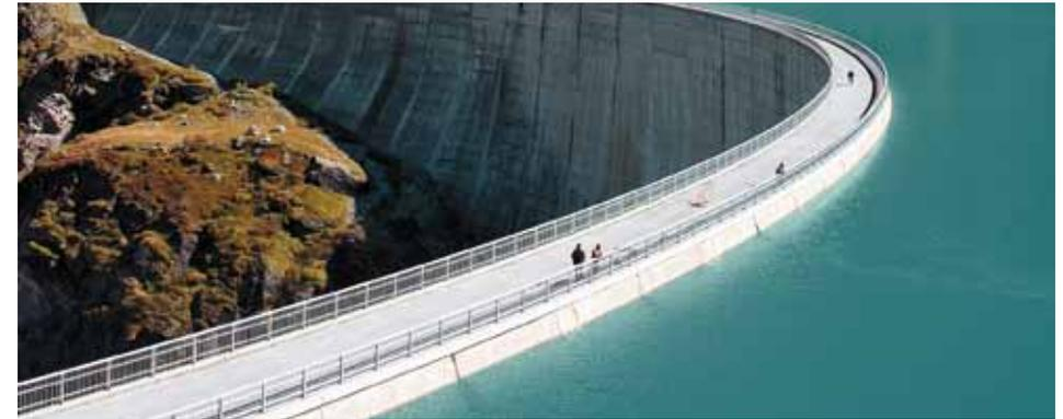
Une chute brute de 1722 m sépare le barrage de Moiry de la vallée du Rhône. La mise en valeur de l'eau accumulée s'effectue en trois paliers successifs avec une centrale à Mottec, une deuxième à Vissoie et une dernière à Chippis. Avec 164 MW installés au total, la production annuelle brute s'élève à 650 GWh dont 52% en hiver.
